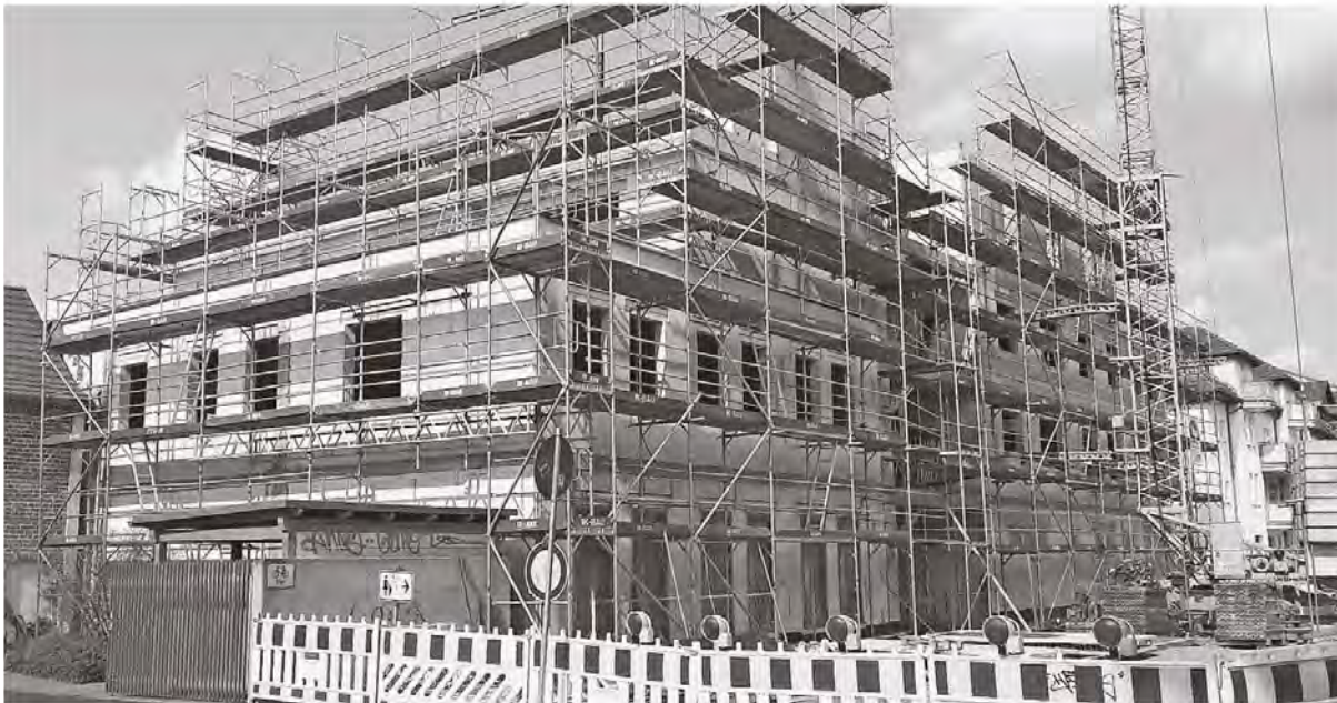
Das Richtfest für das ambulante Kinder-Rehazentrum musste kurzfristig verschoben werden.
